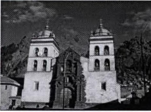
Foto 9: Iglesia San Francisco – Construcción de adobines de caliza Huancavelica – Perú 327
