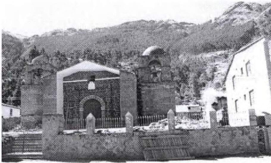
Foto 11: Iglesia construida con adobines de caliza Chusqui - Ayacucho
