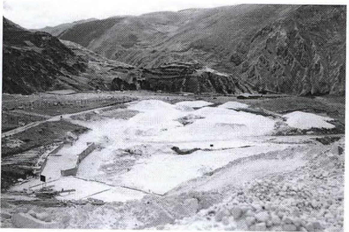
Foto 23 Lavaderos de sílice y almacenamientos en Llocllapampa Jauja - Junín
