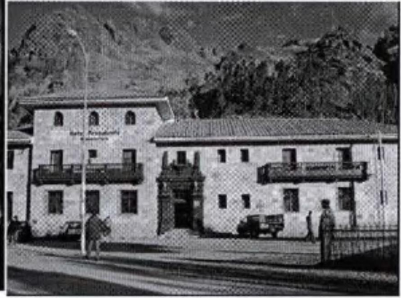
Foto 10: Hotel Presidente – Construcción de adobines de caliza Huancavelica – Perú 328
