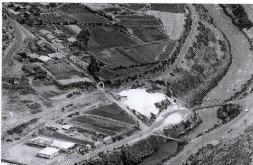
Foto 34: Cancha de almacenamiento de sílice lavada y lista para ser comercializada. cantera Llocllapampa Jauja - Junín
