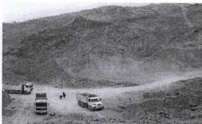
Foto N° 30 Cantera Jesús – carretera al relleno sanitario de Puente Piedra. Cortesía Ing. Segundo Núñez.
