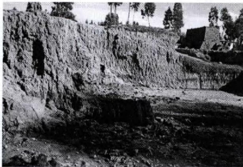
Foto 37 g Frente de cantera de saño – Huancayo – Nov. 2005
