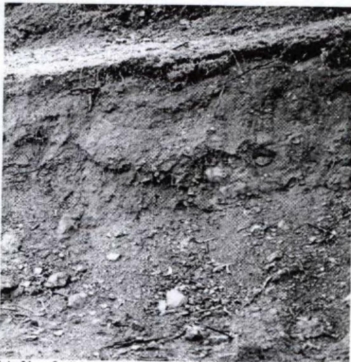
Foto 61 g Corte en carretera de material arcilloso – Mitu - Yanahuanca
