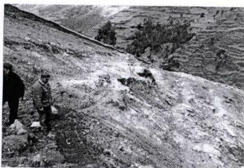
Foto 60 g Vista de ladera con material arcilloso – Tusi II – Nov. 2005
